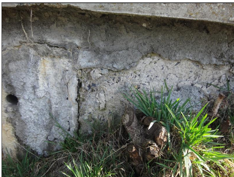
Poruchy křídel na výtokové straně
